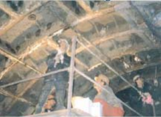
Túnel ICE – Alemanha
